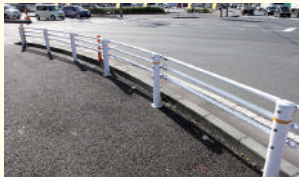
交差点4カ所にガードパイプを設置
